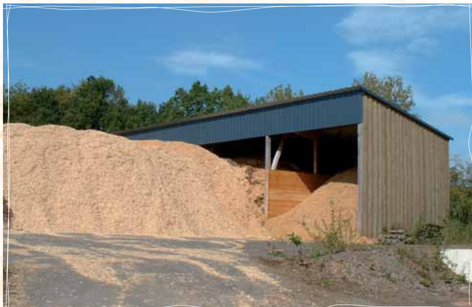
Plate-forme de stockage de plaquettes industrielles temporairement en "sur-stockage"
