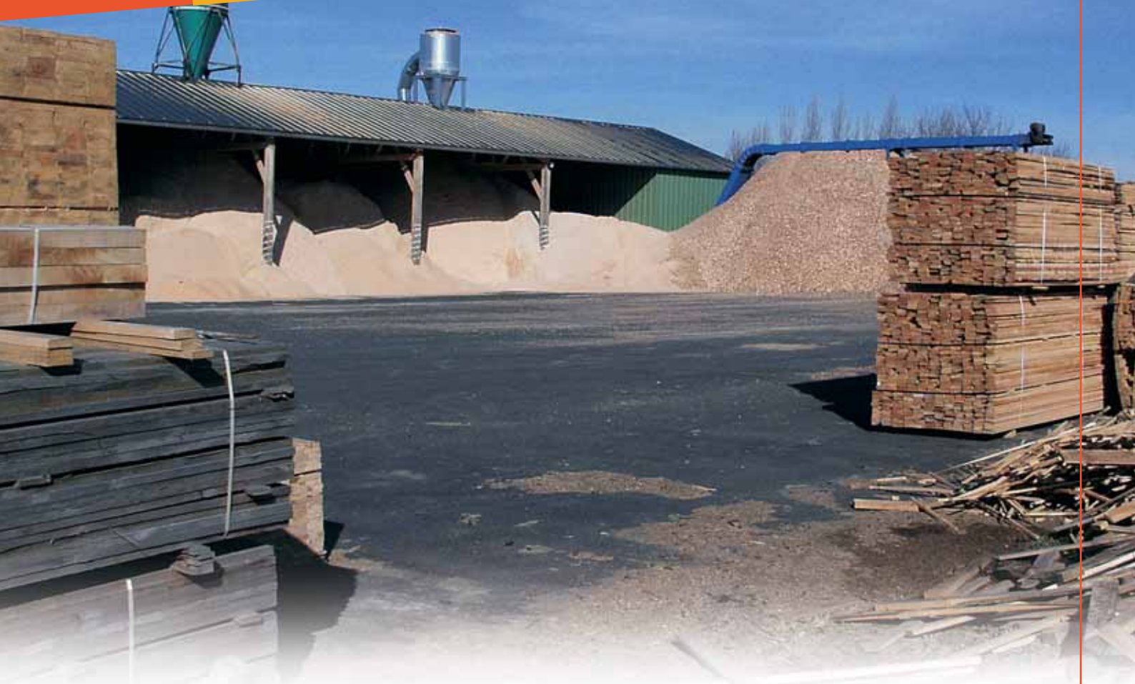
Plate-forme de stockage bois de St-James, en cours de construction
