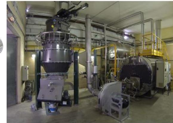
• **BERKES (lit fixe à contre-courant avec chaudière vapeur et turbine)**
